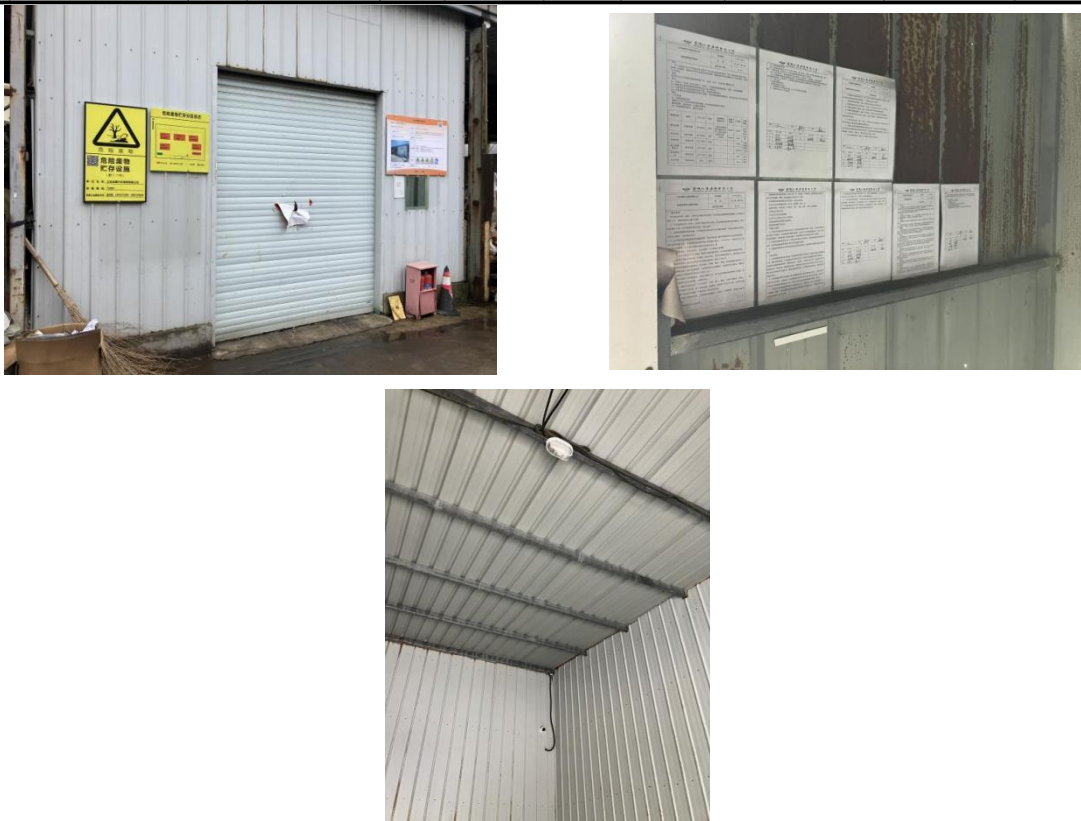
图 4-6 危废库房标识牌及制度
